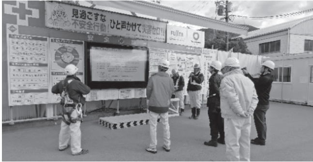
呉トンネル工事
