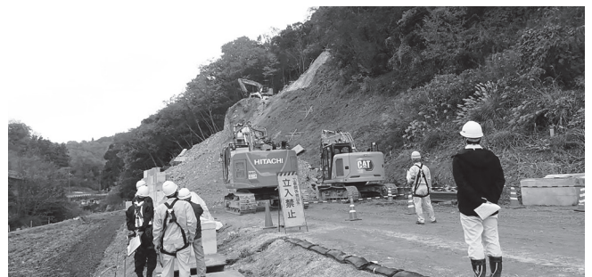
道路改良工事
