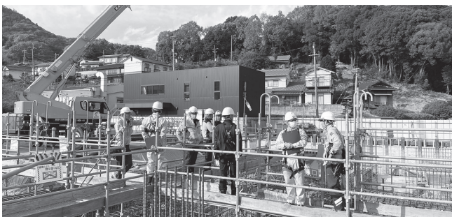
図書館建設工事
